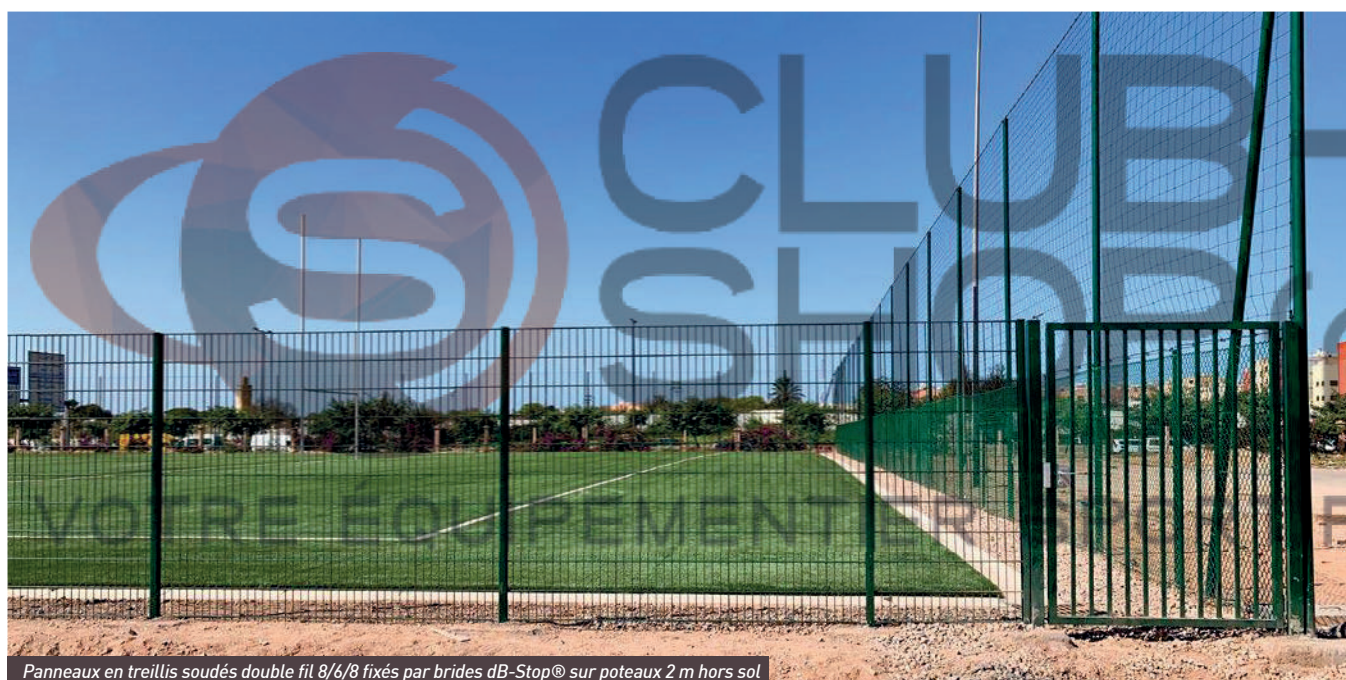
Panneaux en treillis soudés double fil 8/6/8 fixés par brides dB-Stop® sur poteaux 2 m hors sol
